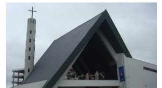
Igreja de Madre Rita construção
