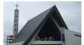
Igreja de Madre Rita construção
